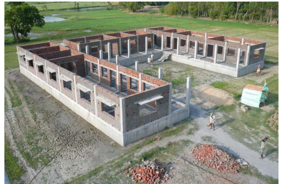
Das Erdgeschoss der neuen Schule in Brindabanchack ist fast fertig
