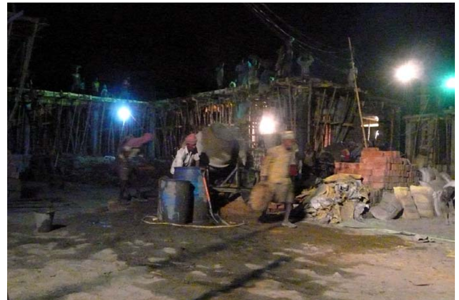
Baustelle bei Nacht: Unermüdlich halfen unsere Arbeiter die Baustelle “monsunfest“ zu machen
